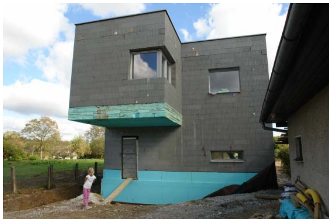
Pasivna hiša Veber, Trinkova ulica, Ljubljana, v gradnji
