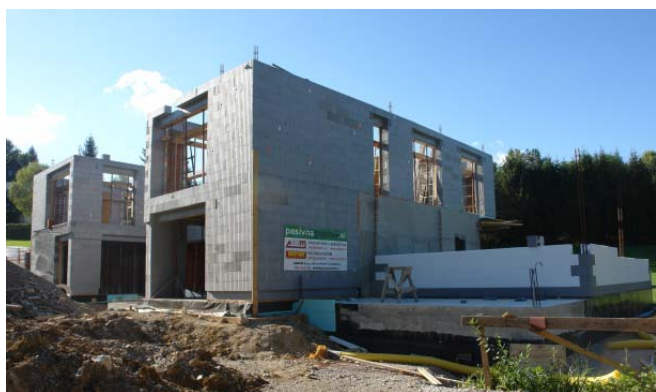
Pasivna hiša Janša, Rašica, v gradnji
