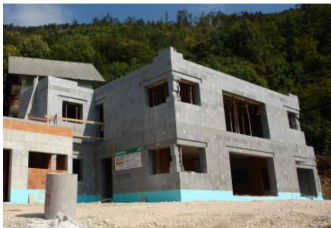
Pasivna hiša Jenko Fefer, Briše, v gradnji
